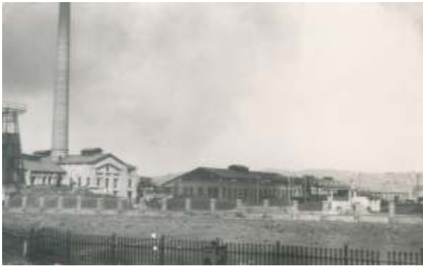
38. Elektrina centrala Prve jugoslavenske tvornice vagona, strojeva i mostova d.d. oko 1925.
