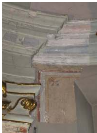
Pogled na unutrašnjost crkve prije i u tijeku radova obnove
