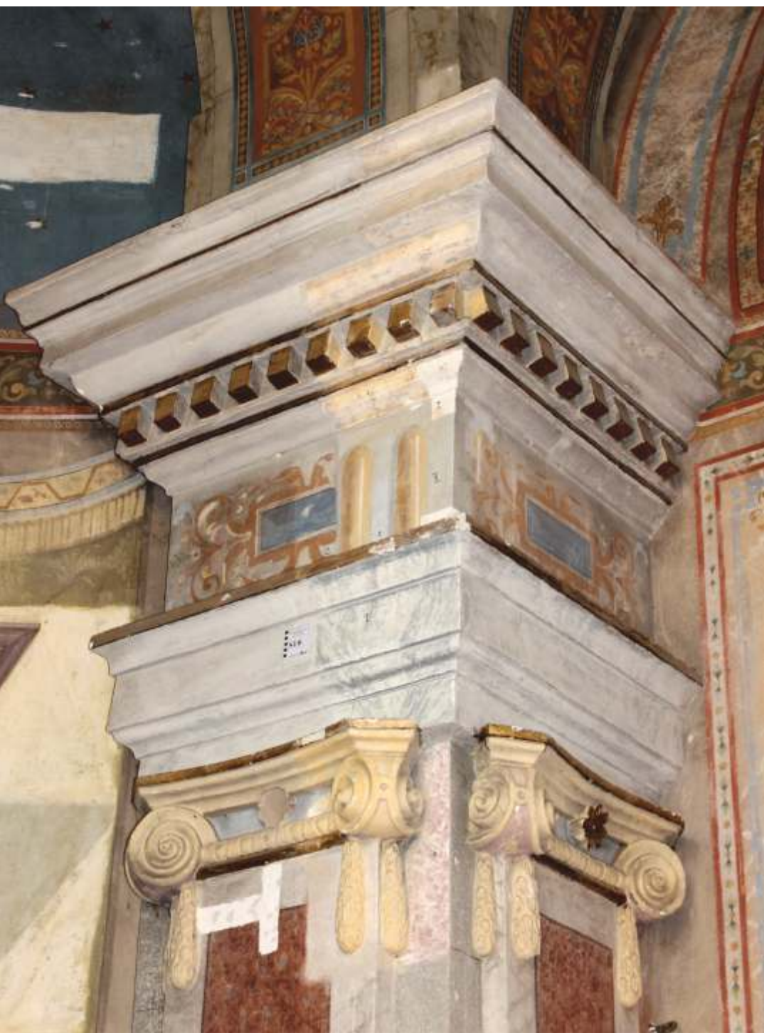
J. Muravić - historicistički zidni oslik – dekorativno oslikana polja pilastra (donji dio); dekorativna traka na susvodnici svodne konstrukcije (gornji dio); župna crkva crkva Bezgrešnog začeća B.D.M. u Novoj Gradiški
